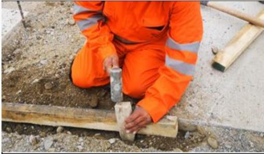
Continuación de lo anterior, golpea la estaca con combo que manipula con la mano derecha, mano izquierdaq sujeta la estaca con postura neutra de muñeca y fuerza leve. Sin uso de guantes.
