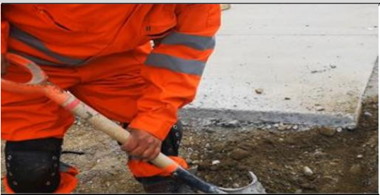
Se observa uso de pala para retiro de material suelto con picota. La toma con ambas manos en agarre con fuerza de mano derecha, muñecas con leve extensión, y movimientos de flexión de codos principalmente. Sin uso de guantes.
