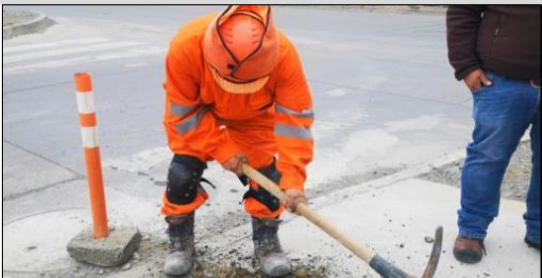
Se observa uso de picota. La toma con ambas manos, agarre con fuerza, abriendo un surco en donde colocará el moldaje. Realiza movimientos amplios de flexoextensión de codos. Sin uso de guantes.
