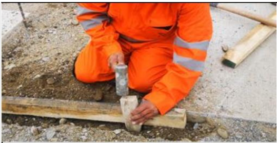
Continuación de lo anterior, golpea la estaca con combo que manipula con la mano derecha, mano izquierda sujeta la estaca con postura neutra de muñeca y fuerza leve. Sin uso de guantes.
