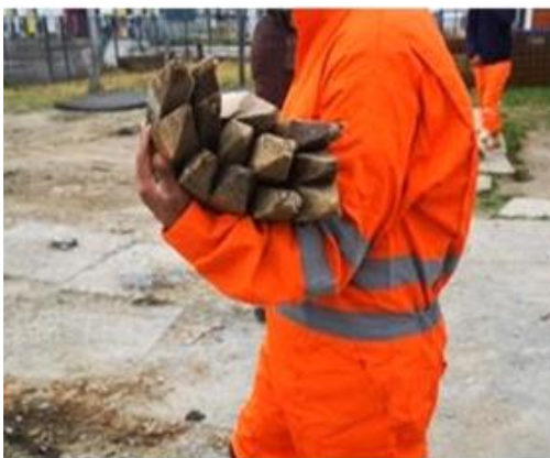
Se observa el transporte de las estacas de madera, con supinación de ambos antebrazos y flexión de ambos codos en 90° desde el camion hasta el lugar de acopio. Sin uso de guantes.
