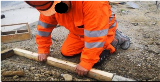
Se observa operación de colocar moldajes previamente cortados. Agarre con ambas manos, fuerza leve y postura de ambas muñecas en extensión. Sin uso de guantes.
